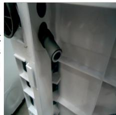
5. Connectez le nouveau tuyau d'évacuation au tuyau des eaux usées.
