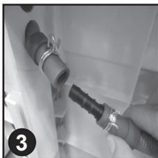
4. Attacher le tuyau noir du kit (en utilisant le connecteur et les clips fournis), au tuyau retiré de la connection en pont.
